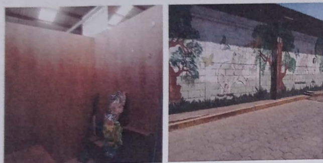
Foto 3: Pintura en muros interior y exterior
