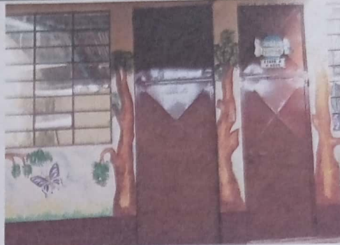
Foto 2: Sustitución de puerta de metal
